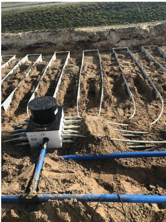
Vier Verteilerschächte verbinden die GeoCollect-Kollektoren mit der Soleleitung. Foto: vor dem Brocke
