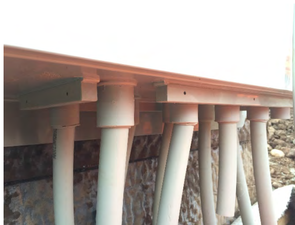
Anbindung der Soleleitungen am Verteilerschacht
