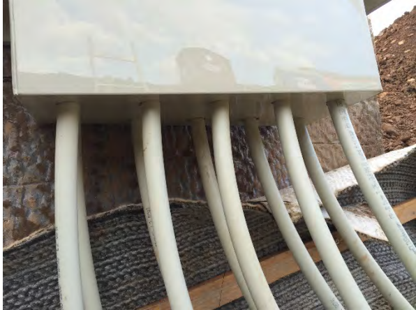
Verkapselung der angebrachten Sole-Leitungen am Verteilerschacht
