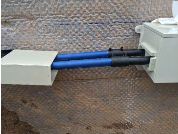
Angeschweißte und danach verkapselte Sammlerleitungen
