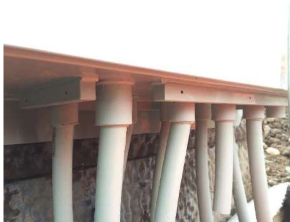
Anbindung der Soleleitungen am Verteilerschacht
