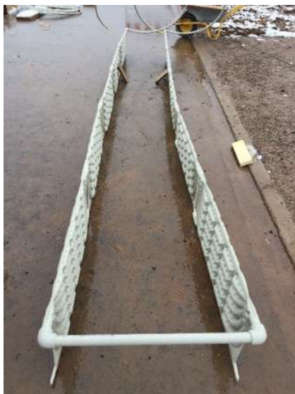
Vormontierter GeoCollect-Strang
