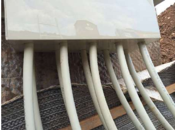
Verkapselung der angebrachten Sole-Leitungen am Verteilerschacht
