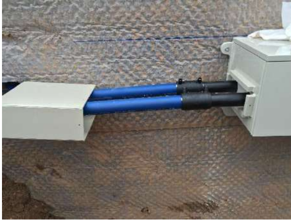
Angeschweißte und danach verkapselte Sammlerleitungen
