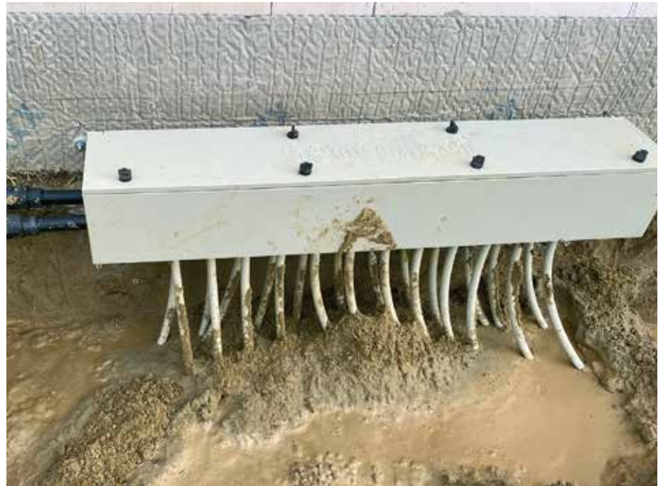
Der Verteiler ist zugänglich an der Bodenplatte montiert. Links die Soleleitungen von und zur Wärmepumpe.
