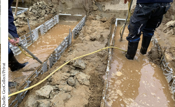
Einschlämmen mit reichlich Wasser optimiert den Kontakt zum Erdreich.
