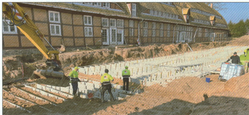
Bild 2: Für die zukunftssichere Wärmeversorgung der 200 Jahre alten Klosteramtsscheune in Dobbertin kommen 1.800 Kollektoren zum Einsatz. Verlegt werden sie auf zwei Ebenen übereinander. Später wird der Bereich als Terrasse genutzt.
