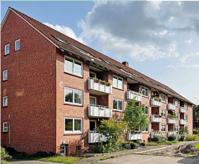
Die Rückseite mit den Loggias und Balkonen blieb ebenso erhalten wie die Wärmeübertragung über Heizkörper. Von den Erdwärmekollektoren ist nach Fertigstellung nichts mehr zu sehen und zu hören
