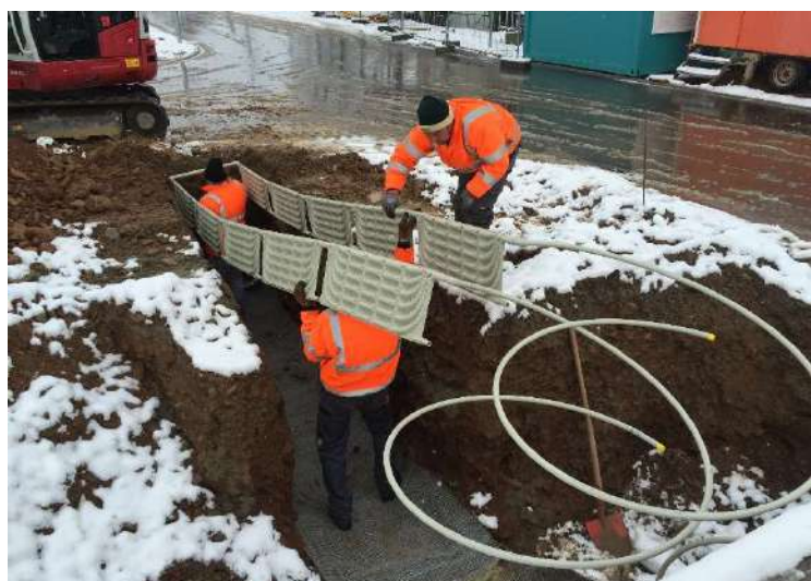
Einbringen des vormontierten Stranges in den vorbereiteten Graben mit 80 cm Grabenbreite und 1,5 m Tiefe (Verlegeabstand 70 cm)
