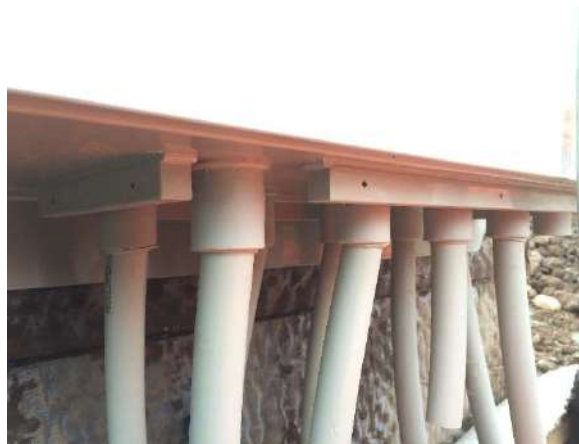
Anbindung der Soleleitungen am Verteilerschacht
