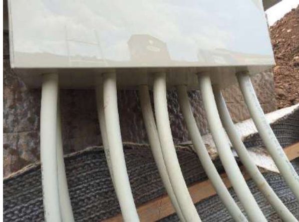
Verkapselung der angebrachten Sole-Leitungen am Verteilerschacht
